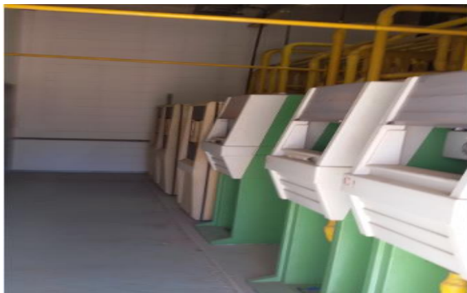
Figura 6 – Sala dos cloradores / dosadores de cloro na ETA RJCS
