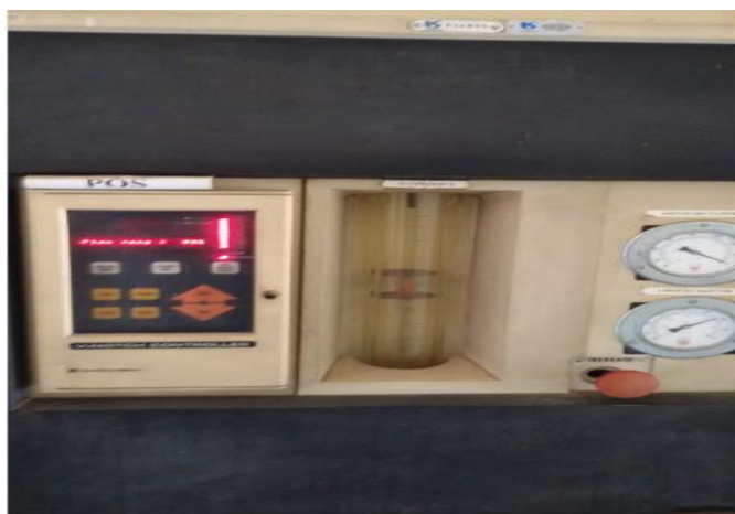
Figura 7 – Sala dos cloradores / dosadores de cloro na ETA RJCS (detalhe do dosador).
