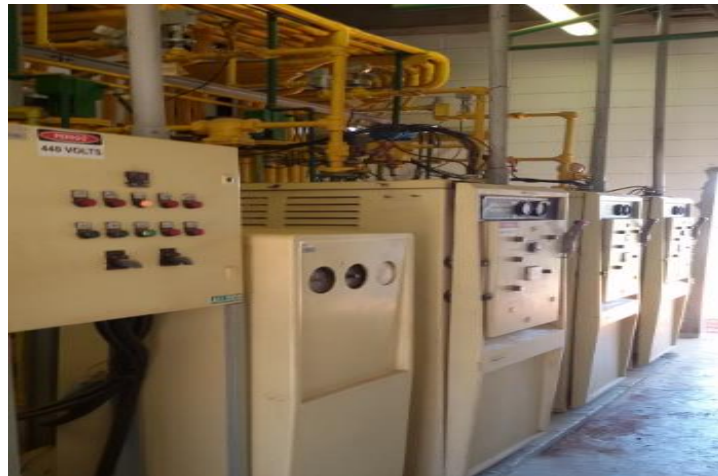
Figura 4 – Sala dos evaporadores na ETA RJCS (vista frontal dos painéis de controle de temperatura)
