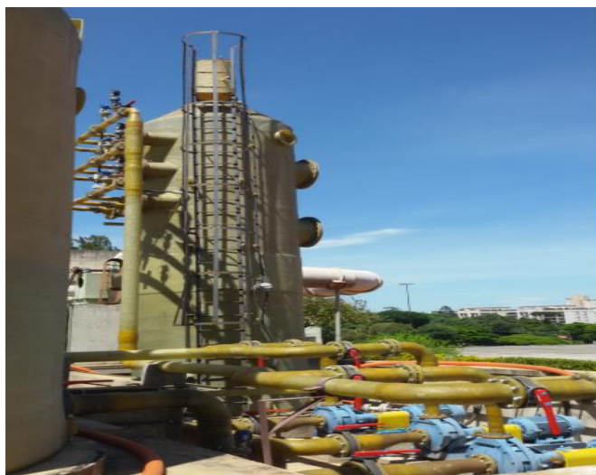
Figura 16 – Torre de Neutralização ainda sem operação com Sistema Integrado de Bombeamento de Soda Cáustica.
