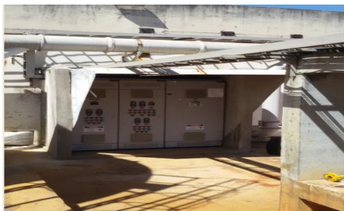
Figura 17 - Painel de comando automatizado em construção para a enviar dados da Torre de Neutralização para o CCO.
